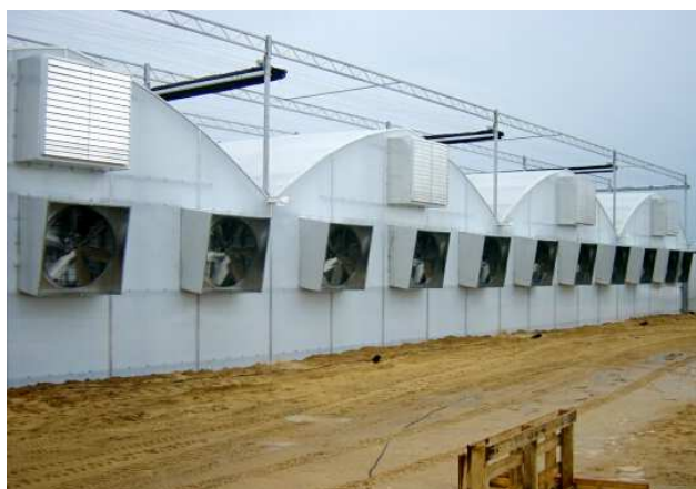
Invernadero moderno con pantalla exterior y sistema de enfriamiento
