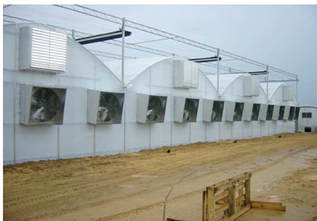
Moderno invernadero con sistema de refrigeración y pantalla exterior
