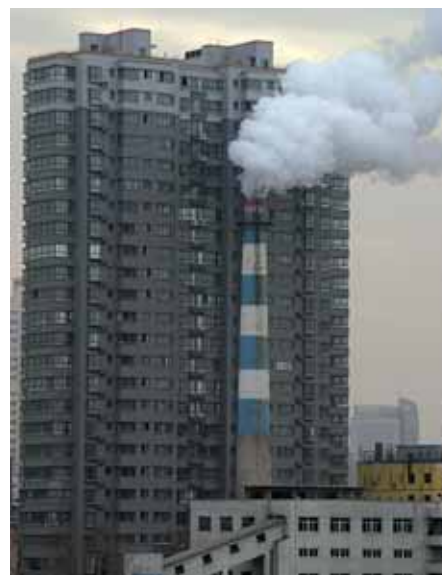
Vooruitlopend op de sloop van een energiecentrale, is de bouw van een nieuwe flat al begonnen... en afgerond.
