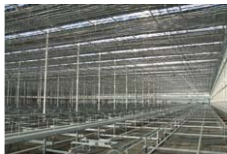
Het diafragmascherm® in het nieuwbouwproject van Anthura
