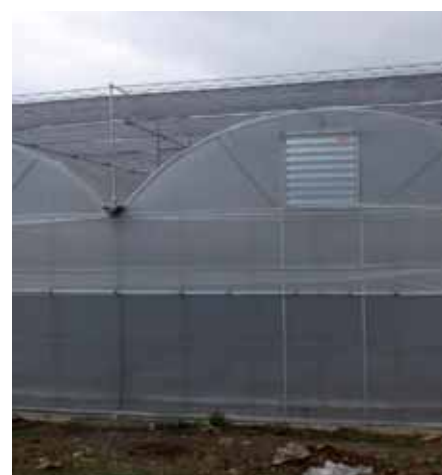
Esterno della serra di esposizione. Didascalia: Duplice copertura in plastica e schermo interno ed esterno.
